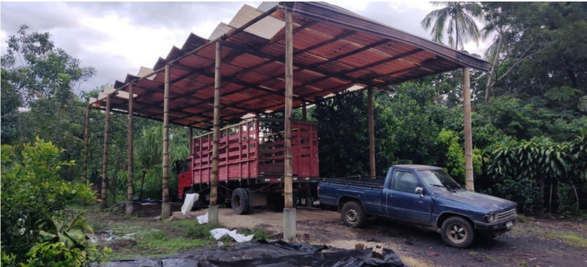
Figura 10: Análisis de infraestructura
