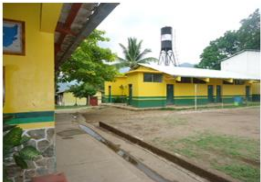
Al frente: Baños de estudiantes. Al fondo: Tanque que abastece de agua al centro educativo; entrada principal al área agropecuaria.
