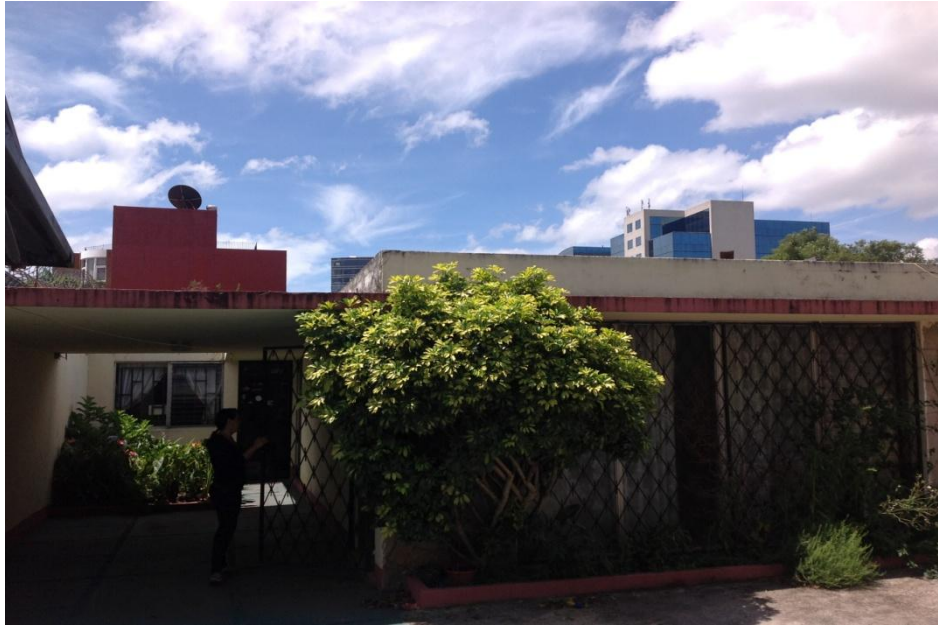
Foto: Vista frontal del ingreso a las instalaciones de la empresa, julio 2013
