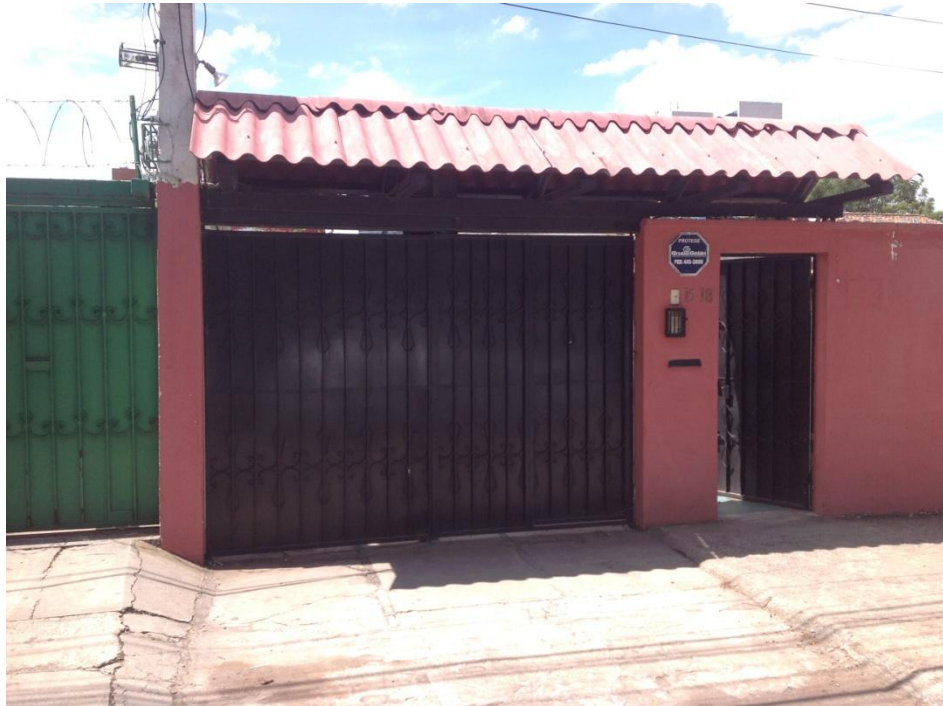
Foto: vista frontal de la fachada de la empresa, julio 2013
