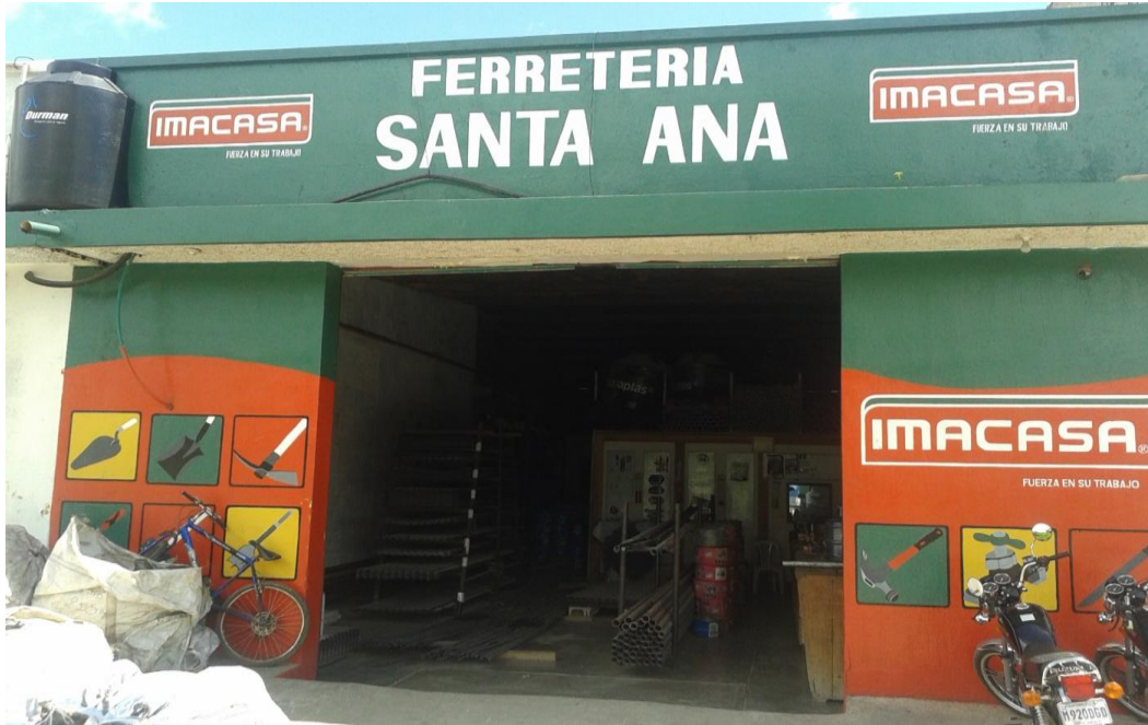
Nueva fachada de Ferreteria Santa Ana No.1
