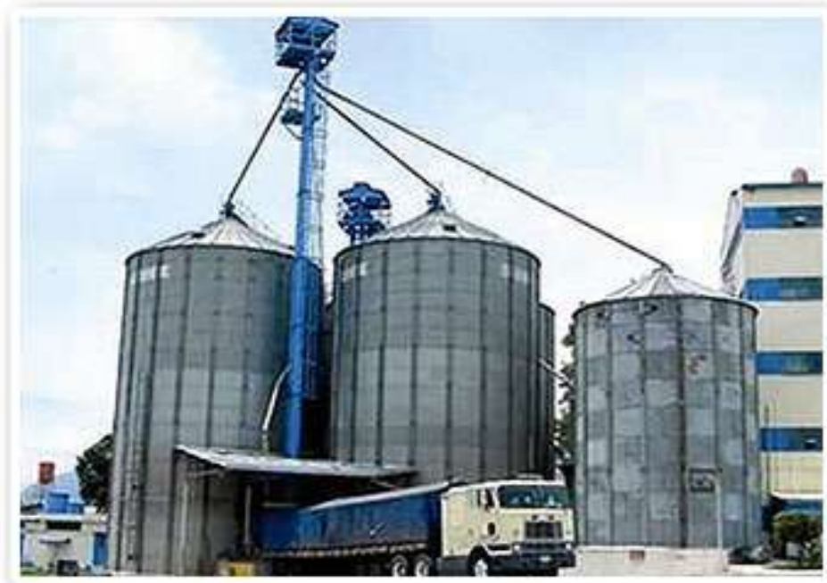
Foto: Silos de almacenamiento de trigo, para remojar y procesar el trigo
