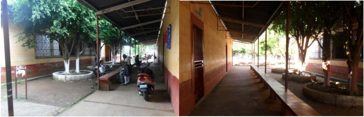
Pasillos principales del edificio.
