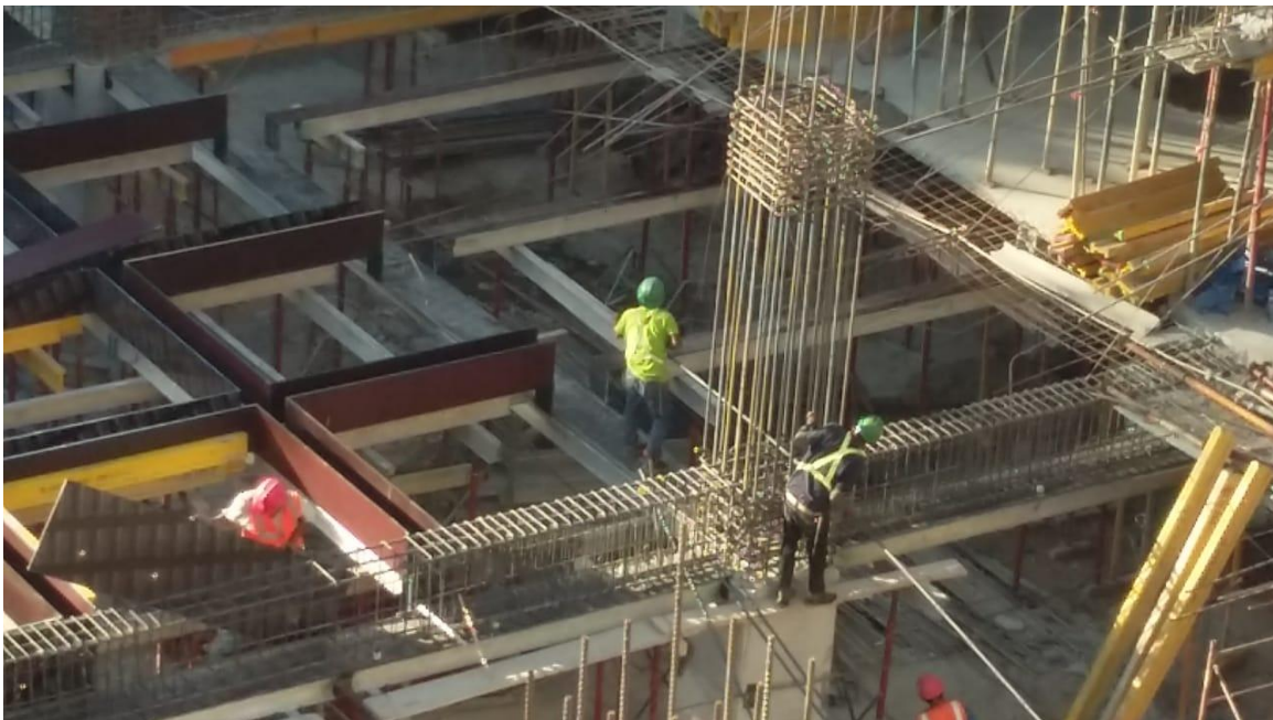
Imagen No. 4 Trabajo de construcción de Grupo Multiconcretos –MC-
