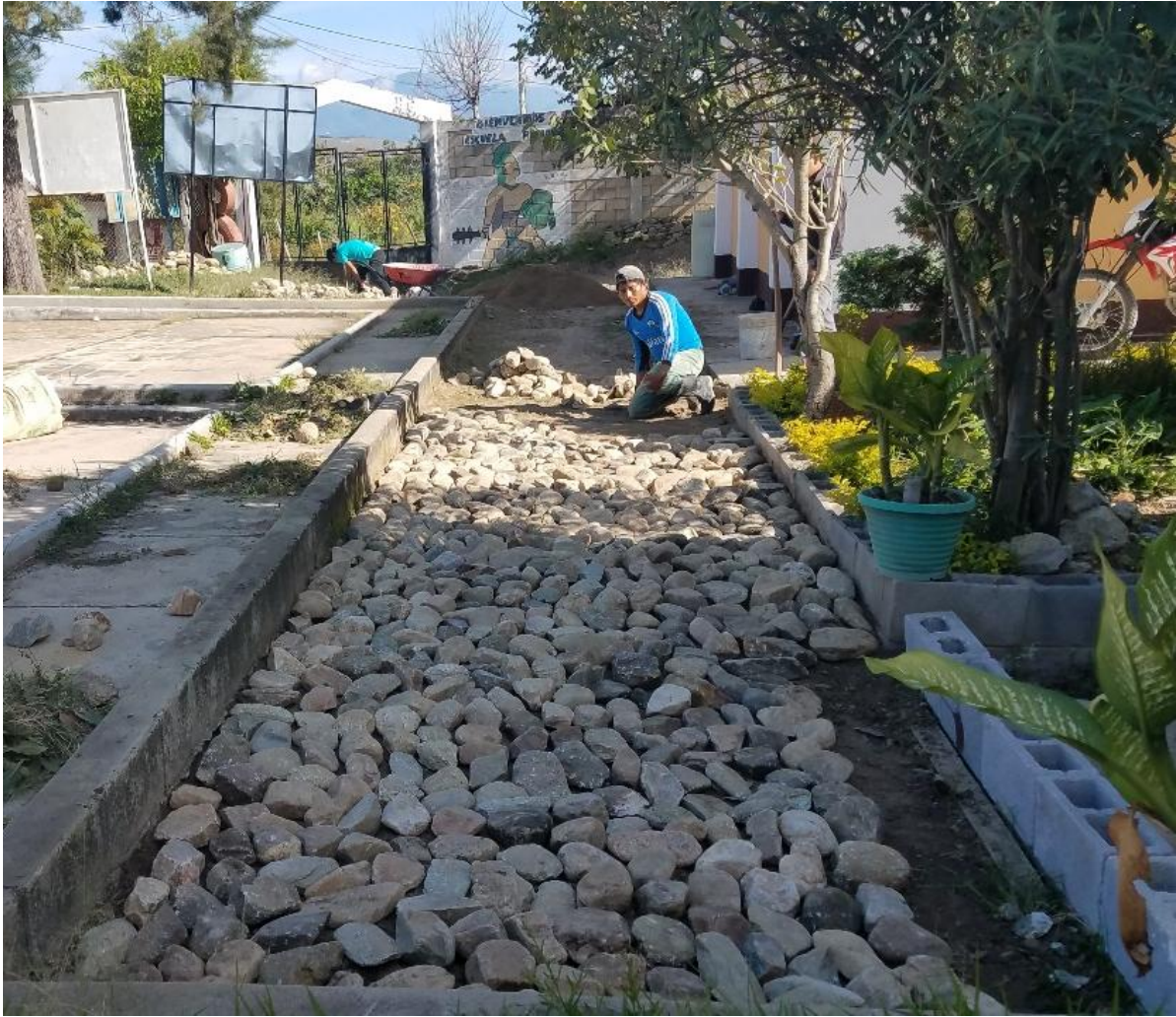
Durante la ejecución de limpieza y relleno
