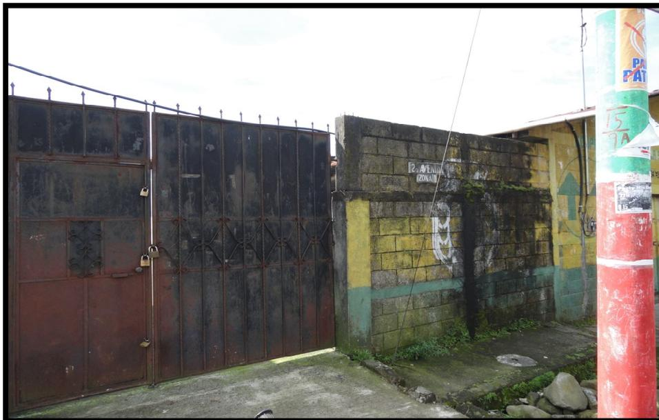
Paredes con bastante humedad propensos a grietas por sismos.
