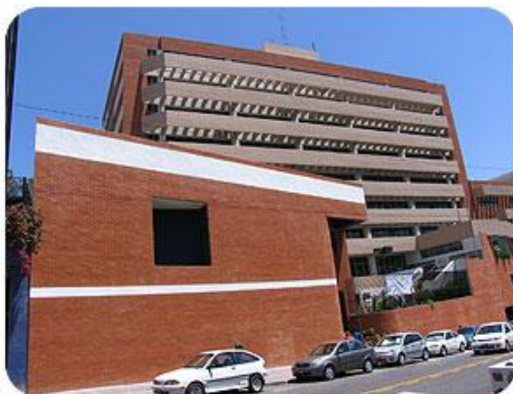
Edificio de INTECAP actualmente
