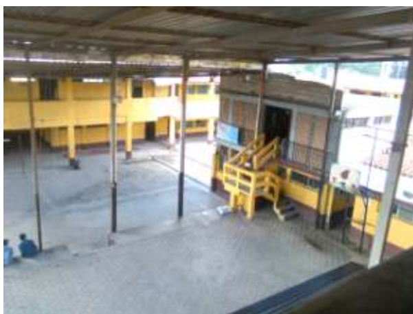
Instalaciones y áreas deportivas
