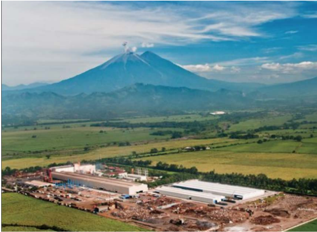
Planta ubicada en Masagua Escuintla
